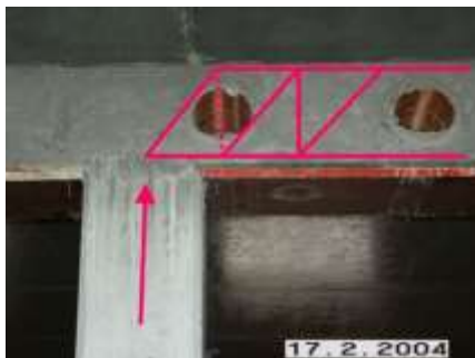
Nachträglicher Rohreinbau, wodurch die Wirkung der gedachten "Druckstrebe" im Beton wegfällt.
