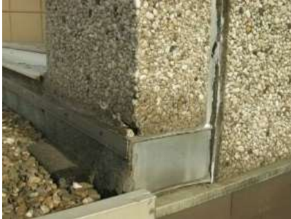
Verschobene Fassadenplatte.
