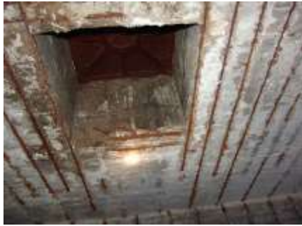
Untersicht Decke und Schachtdeckel
